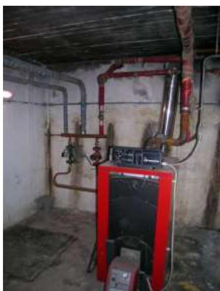
24 Caldaia pellets
